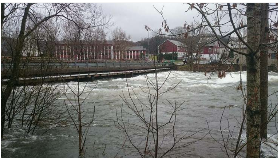
Bjerkeim sentrum sett fra vestsiden av brua. Brua avstengt med traktortilhengere på begge sider.
