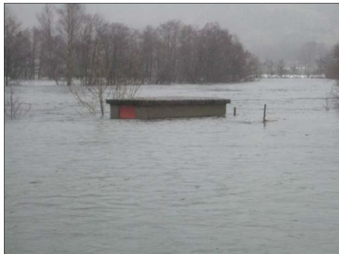
Pumpehuset for vatningsanleggene på Oremo
